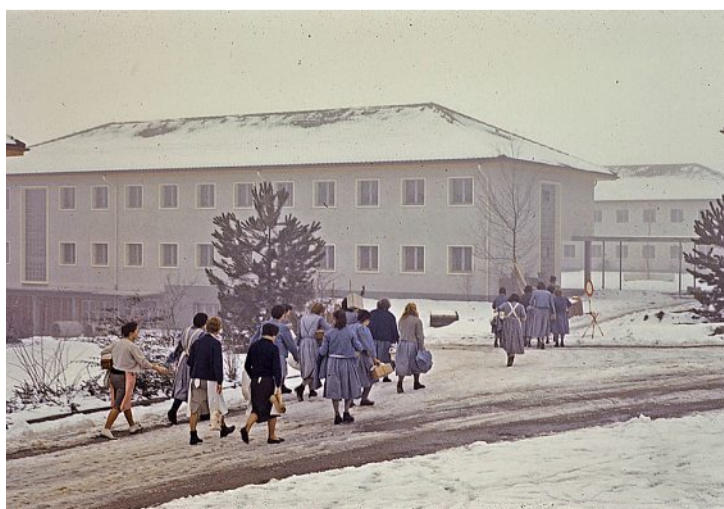
Die Insassinnen ziehen 1960 in die neuen Gebäude um.
